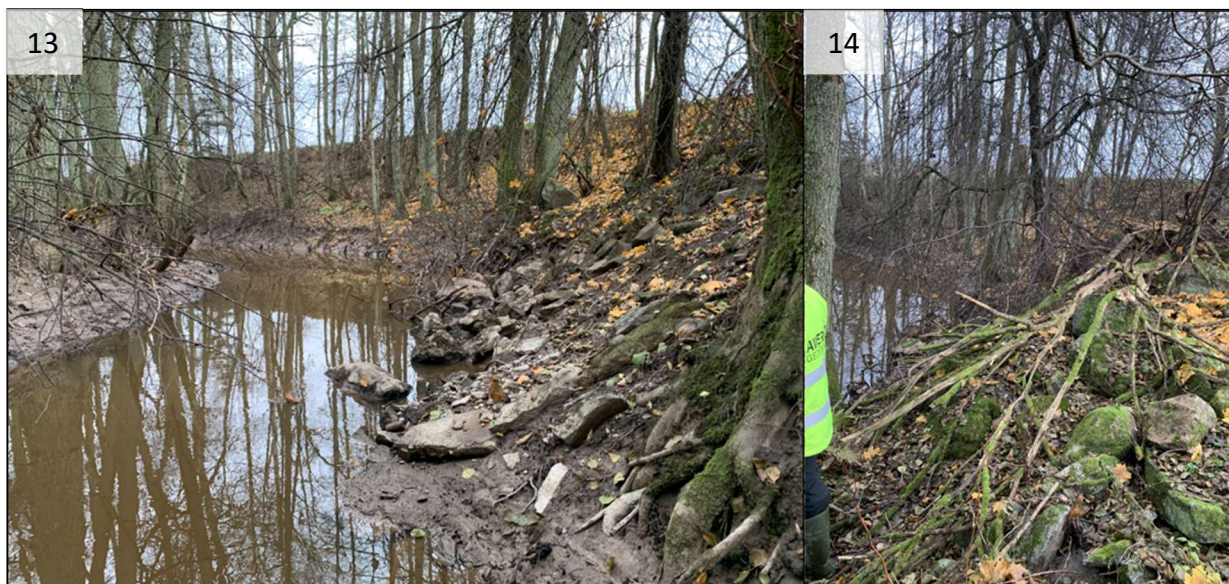
Figur 3-7 – (13) Gammalt erosionsskydd längst ner i slänten. (14) Gammalt erosionsskydd högre upp i slänten.
